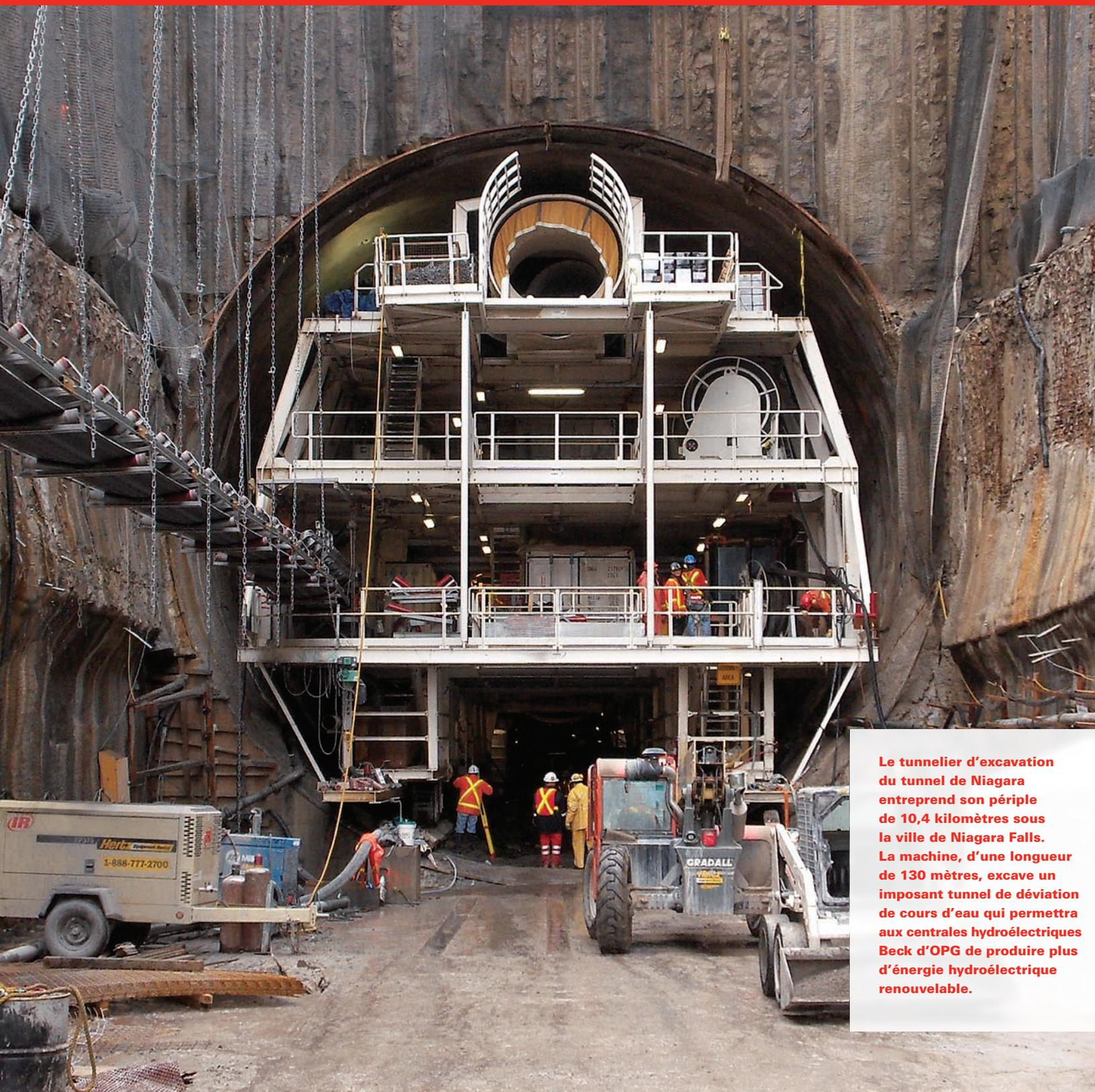
**Le tunnelier d'excavation du tunnel de Niagara entreprend son périple de 10,4 kilomètres sous la ville de Niagara Falls. La machine, d'une longueur de 130 mètres, excave un imposant tunnel de déviation de cours d'eau qui permettra aux centrales hydroélectriques Beck d'OPG de produire plus d'énergie hydroélectrique renouvelable.**
